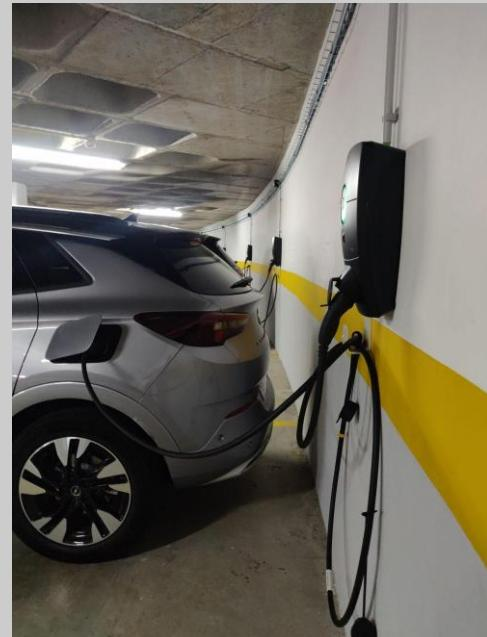
O carregador Zaptec Pro está permanentemente ligado à internet e recebe atualizações do seu firmware para que reconheça sempre qual o modelo de automóvel está ligado à estação. A estação está também em comunicação com os outros Zaptec Pro no mesmo parque e partilha a energia entre eles para que, no fim do dia, todos tenham carregados o máximo possível.
