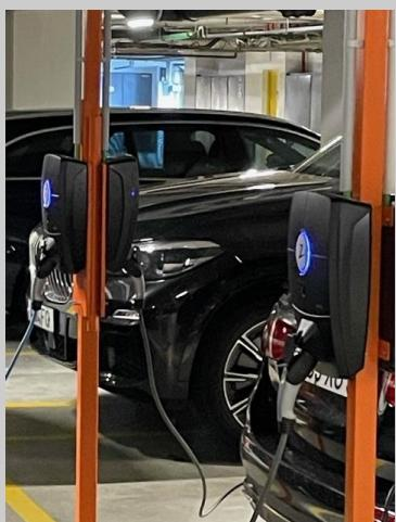
O Zaptec Pro é uma solução de carregamento de veículos elétricos inteligente que permite carregar muito mais veículos do que outras soluções, sem aumentos de potência instalada. Num circuito de 64 Amperes e um cabo apenas, o sistema Zaptec Pro carrega até 50 veículos elétricos, simultaneamente! Não acredita? Venha ver, ligue-nos agora e vamos visitar uma garagem onde estão mais de 130 veículos a carregar ao mesmo tempo!
